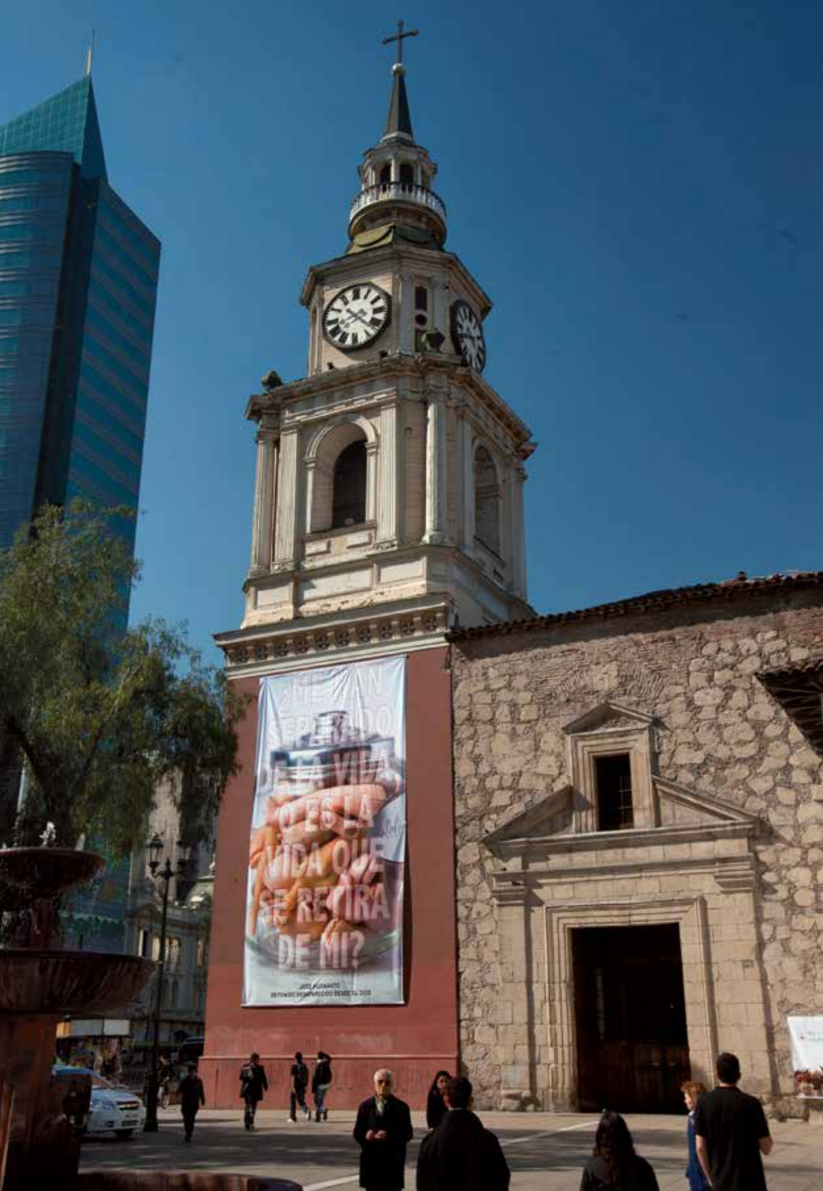
En otra de las paredes laterales del campanario de la Iglesia San Francisco fue descolgada la Obra de Carlos Montes de Oca.
